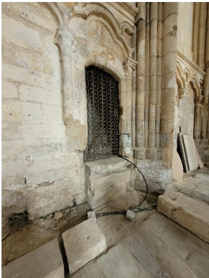
Figure 16 : porte qui mène au clocher
