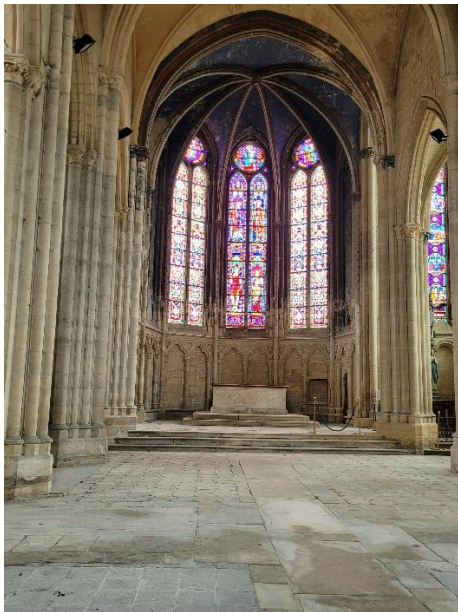
Figure 10 : Pilier avec colonne anormale avec reprise de 3 arcs sur la même
