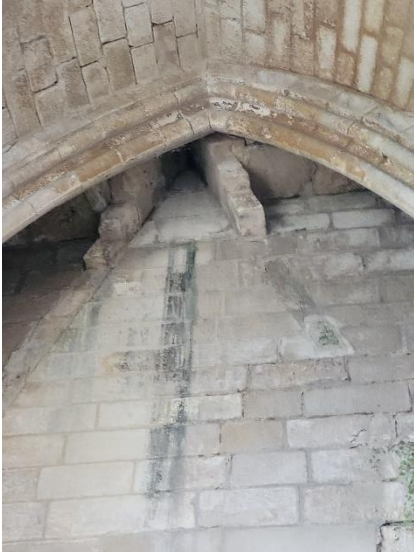
Figure 15 : conduit de cheminée
