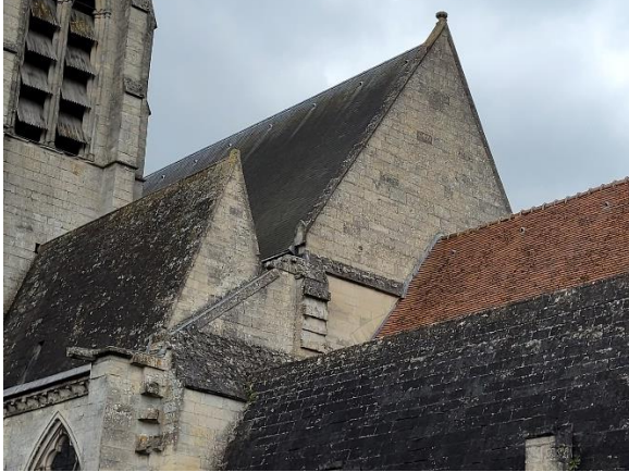
Figure 1 : Des toits à différentes hauteurs, des harpes de pierre et un pignon « d'attente »
