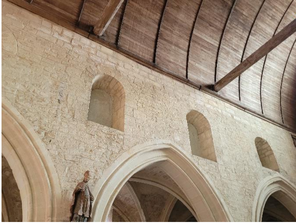
Figure 4 : la partie romane modifiée (les fenêtres condamnées et les arches gothiques)
